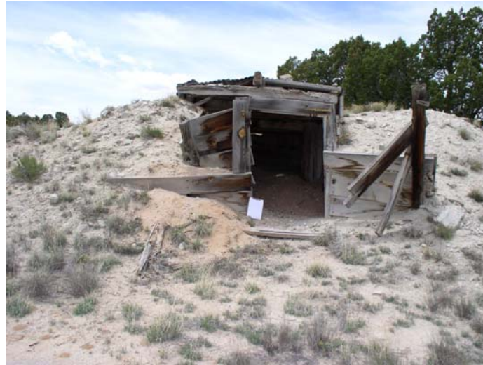
P2: Dog Mine structure
